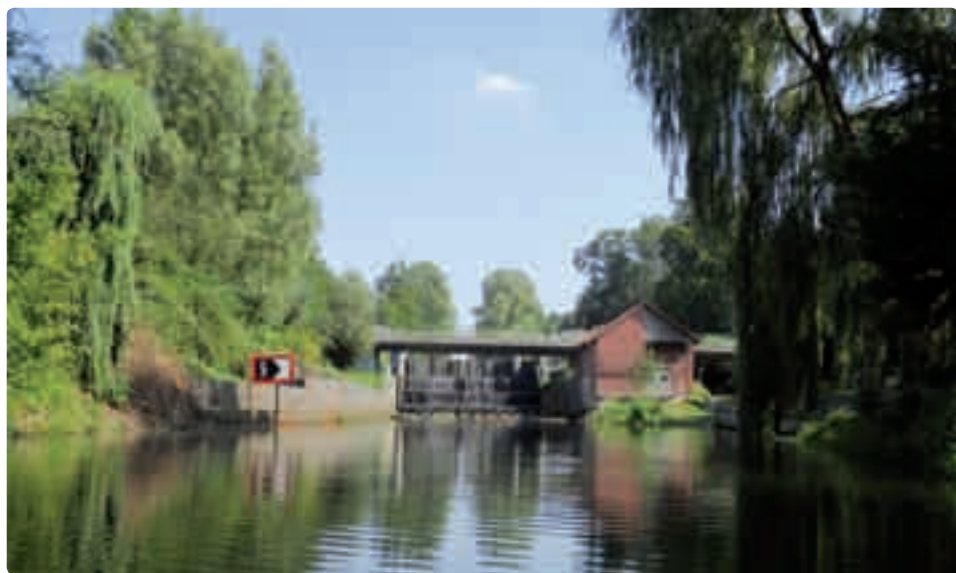
Kaskadenwehr vor dem Spree-Dahme-Umflutkanal
