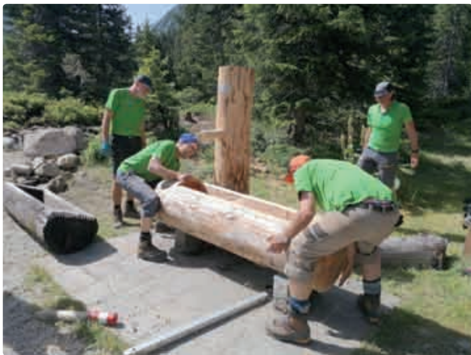
Der neue Trog wird installiert
