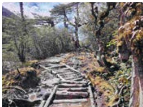
Der Weg war einmal gut ausgebaut, jetzt mit vielen Defekten
